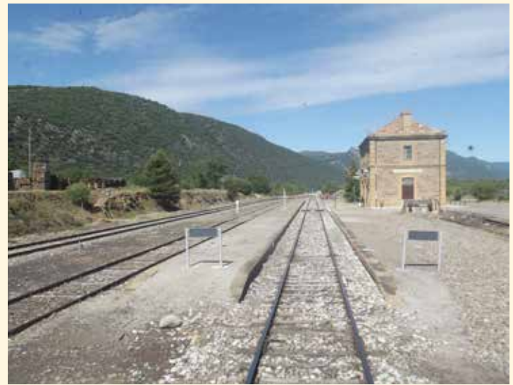
Estación de Santa María y La Peña, lado Jaca. En la actualidad, esta estación está rebajada a apartadero sin servicio, aunque los cambios de vía están activos, pudiendo intervenir en la explotación si fuera necesario.
