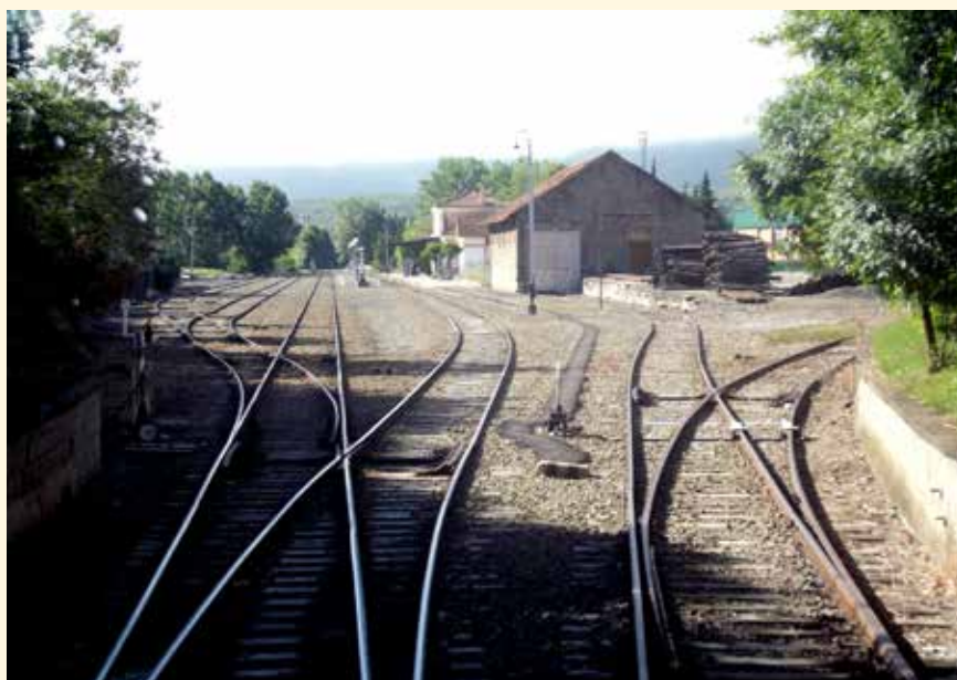
Vías de entrada de la estación de Jaca, lado Canfranc.
