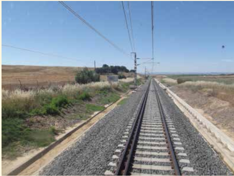
Vía electrificada y con tres carriles entre Huesca y Tardienta.
