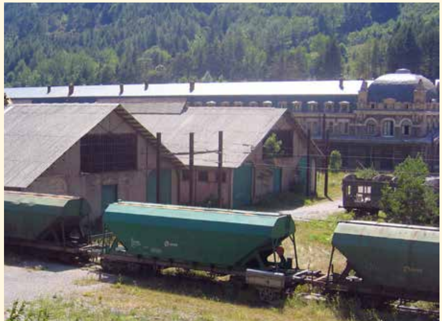
Vagones tolva para el transporte de maíz, en la zona de carga del silo de Canfranc. (Foto Jürg Suter).
