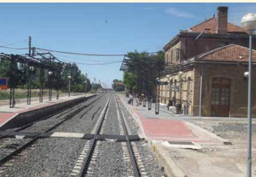
Estación de Ayerbe, la única en servicio entre Huesca y Sabiñánigo.
