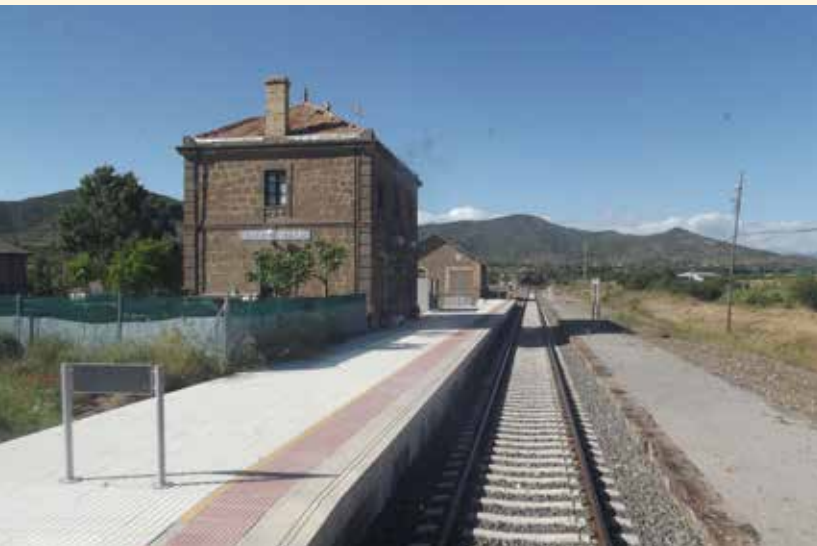
Apeadero de Caldearenas-Aquilú, lado Huesca. La mayor parte de los apeaderos de la línea han sido renovados en los últimos años.
