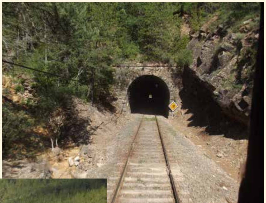
Uno de los túneles del tramo Canfranc-Jaca, con limitación a 30 por humedades en el interior.
